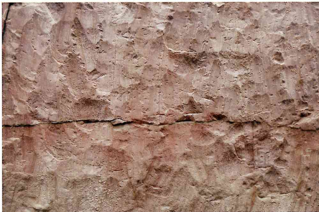
天井や壁には工具の痕が明瞭に残っています。
