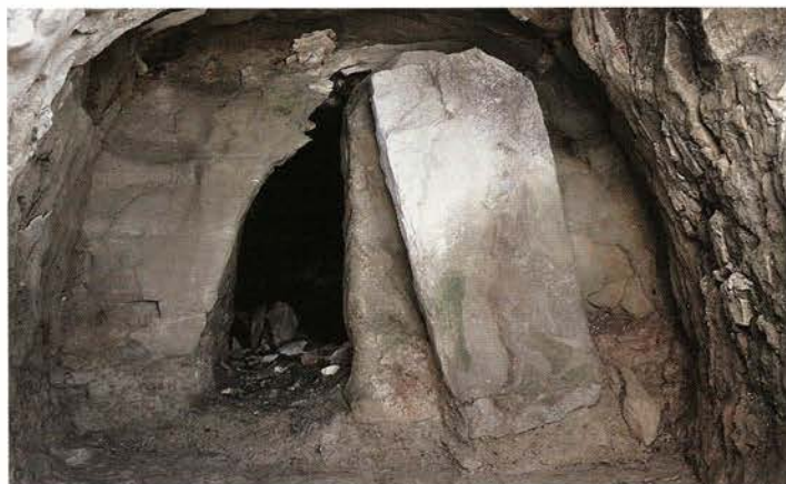
左側の閉塞石が動かされ、大人一人がやっと通り抜ける隙間ができていました（調査前）
